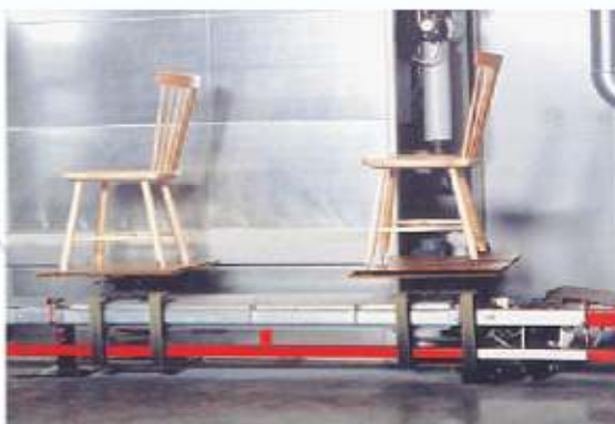
Transportador con cadena al suelo (Línea de barnizado automático)
