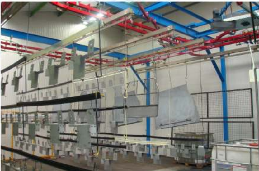
Transferencias de vigas transversales sobre vías paralelas motorizadas
