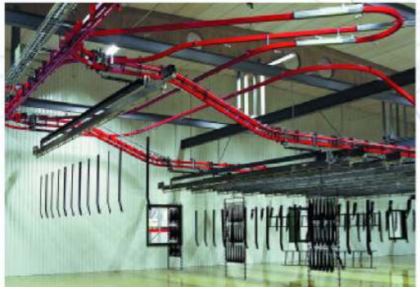
Zona de almacenamiento sobre vías paralelas con desnivelado
